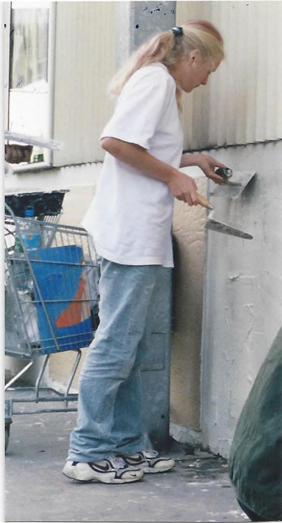
La pose des panneaux
